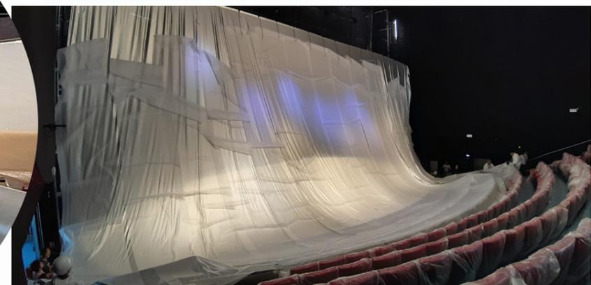
L'écran a d'abord été déroulé dans la salle avant d'être hissé à sa place définitive. Il est installé sur une structure métallique équipée de «shaker» qui le font vibrer lors des projections pour optimiser le rendu visuel.
